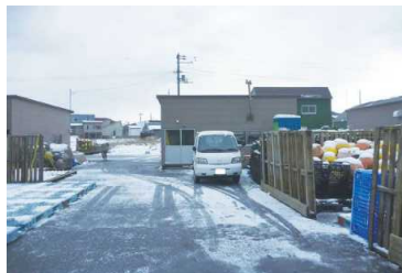
養殖作業倉庫
